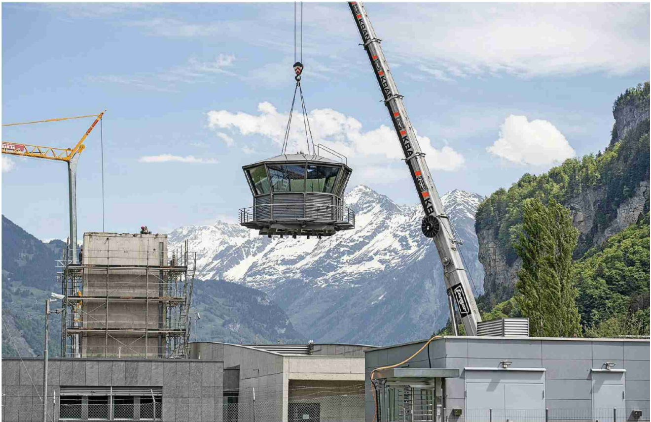
Die Kanzel des alten Kontrollturms wird mithilfe eines Krans abgebaut. Foto: Urs Flüeler (Keystone)
